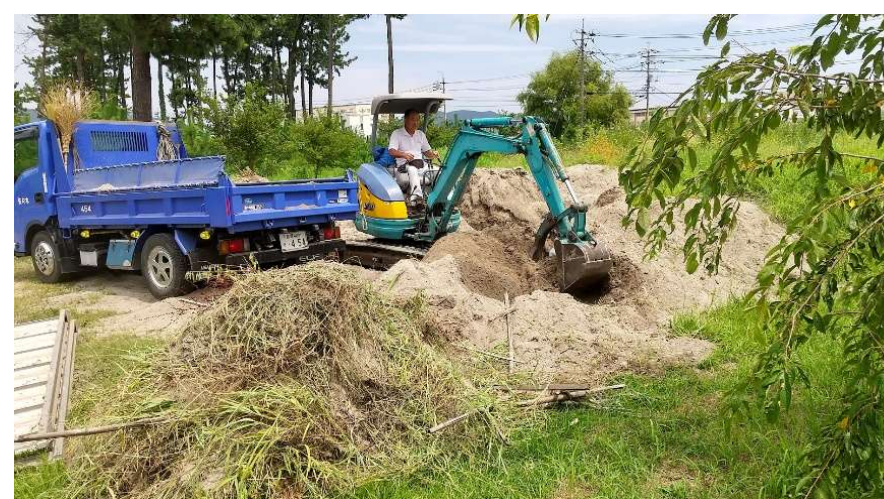
左側図：6月～7月頃まで草刈り作業。右側図：8月公共残土の場内小運搬と凸凹地への埋戻し・整備均し
